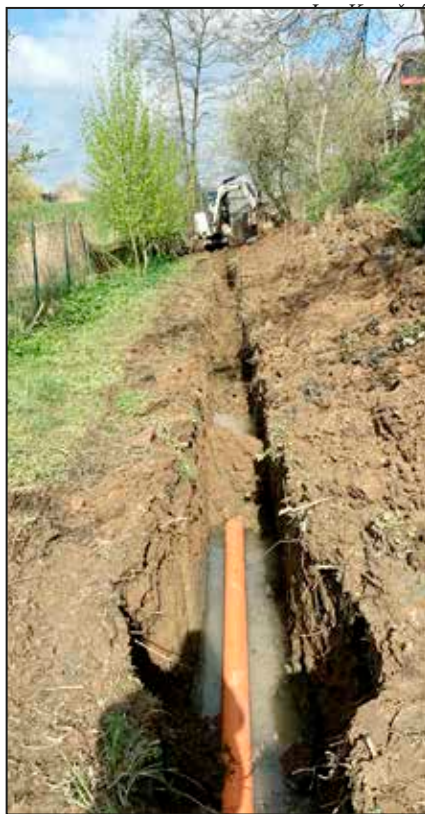
Stavba přiváděče v Lošticích
