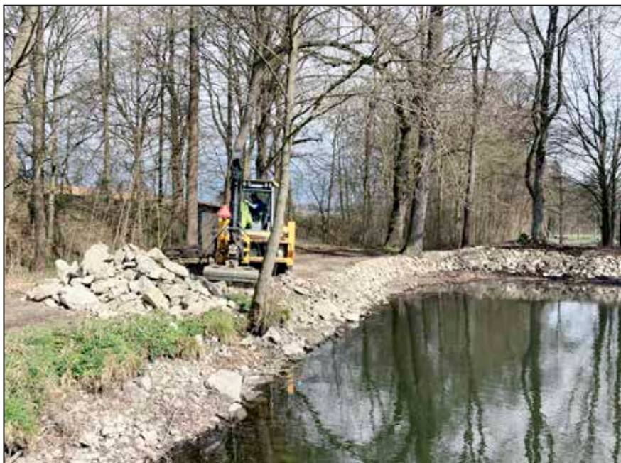
Oprava hráže rybníka Fučík
