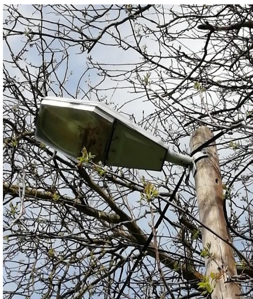
Obr. 17 Nečistoty v difuzoru
