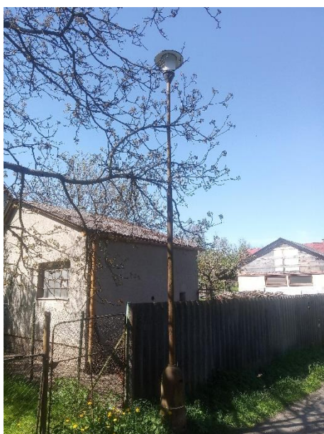
Obr. 20 Koroze stožáru
